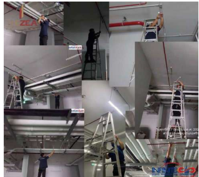
ภาคผนวกที่ 3.31 ช่างอาคารทำการเปลี่ยนหลอดไฟส่องสว่างลานจอดที่ชำรุด
