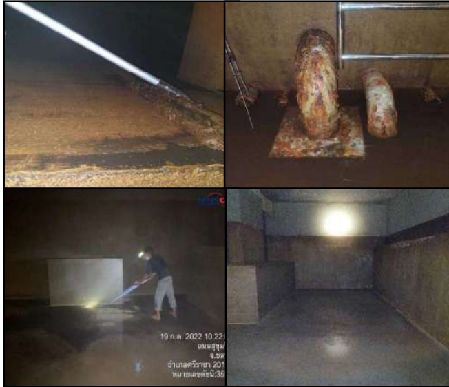
ภาคผนวกที่ 3.44 ล้างถังสำรองน้ำาดไฟฟ้า และใต้ดิน
